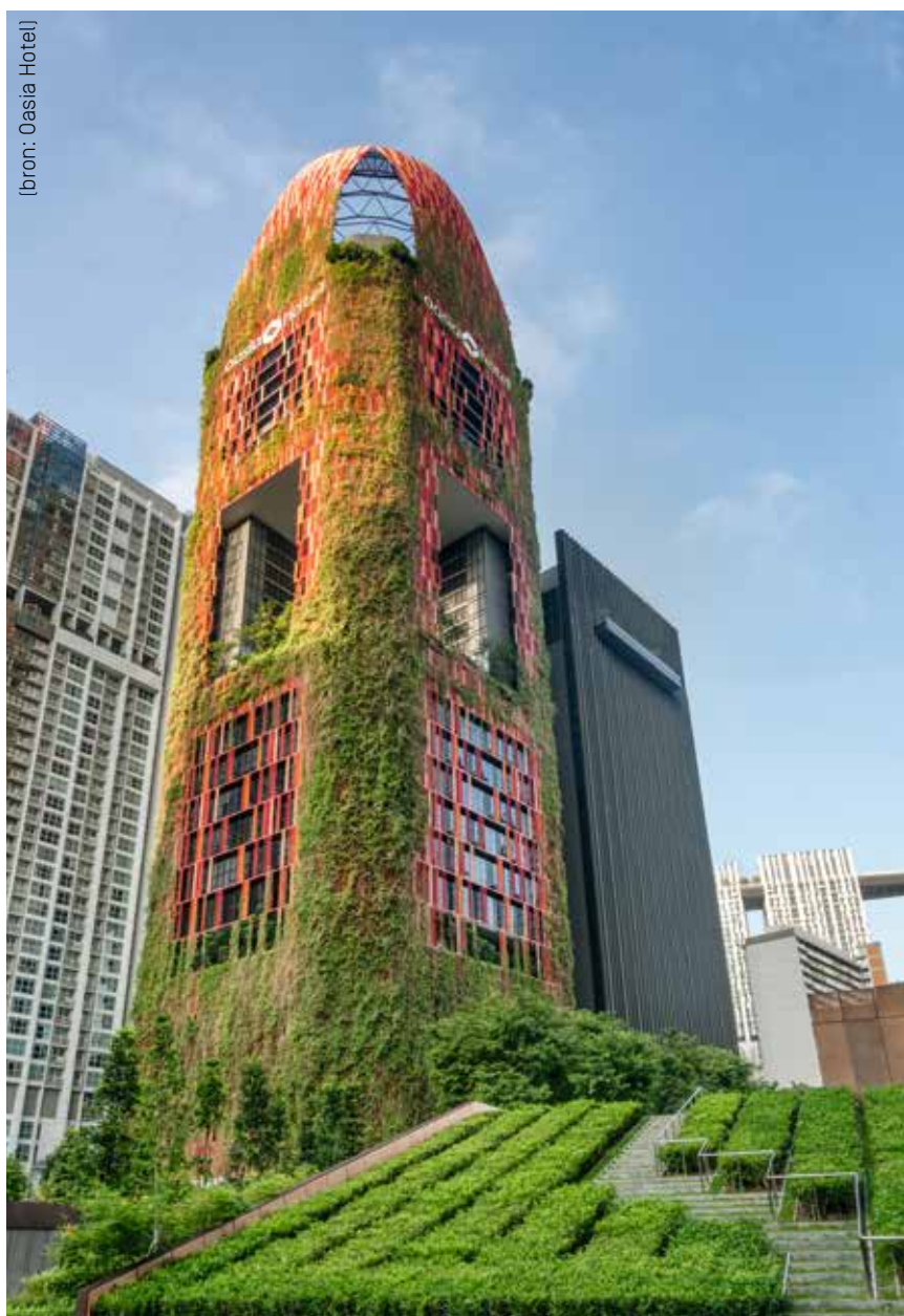
Het Oasia Hotel in Singapore. De groene gevel zorgt voor koeling van het gebouw.
