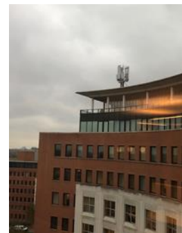
Foto Antenne op daklocatie
